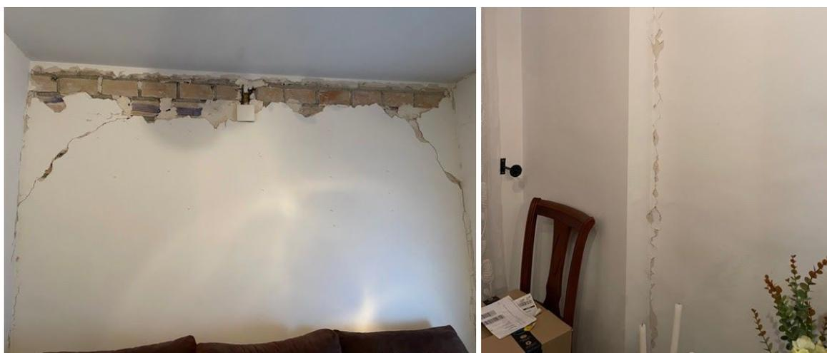
Figura 5. Daños observados en la población de Atarfe tras el terremoto de Mw 4,4 del 23/01/2021. ACELERACIÓN
